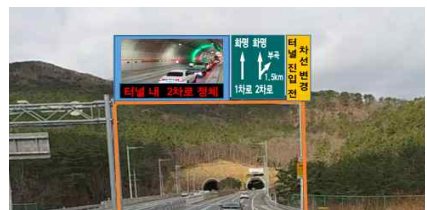
■ 풀컬러 영상전광판 설치
